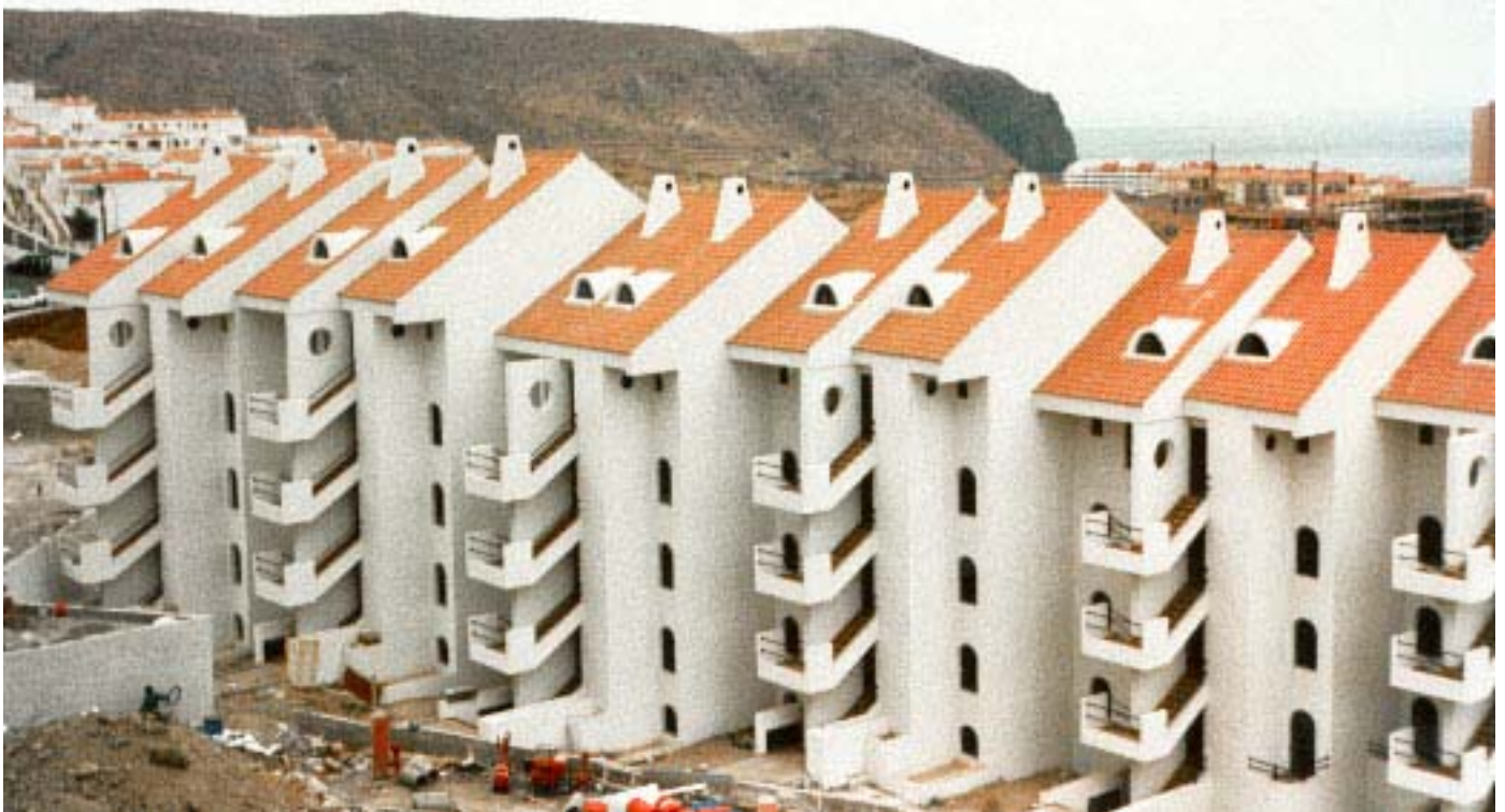
Vista general del antes y después de la aplicación de CONCRESEAL PLASTERING
