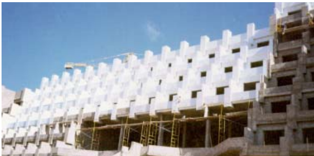
Fachada durante aplicación de CONCRESEAL PLASTERING
