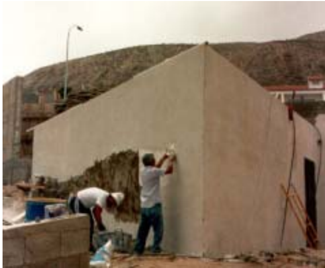
Trabajos de aplicación de CONCRESEAL PLASTERING
