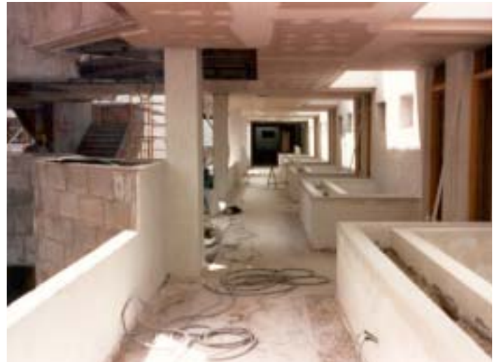
Pasillos interiores tras aplicación de CONCRESEAL PLASTERING
