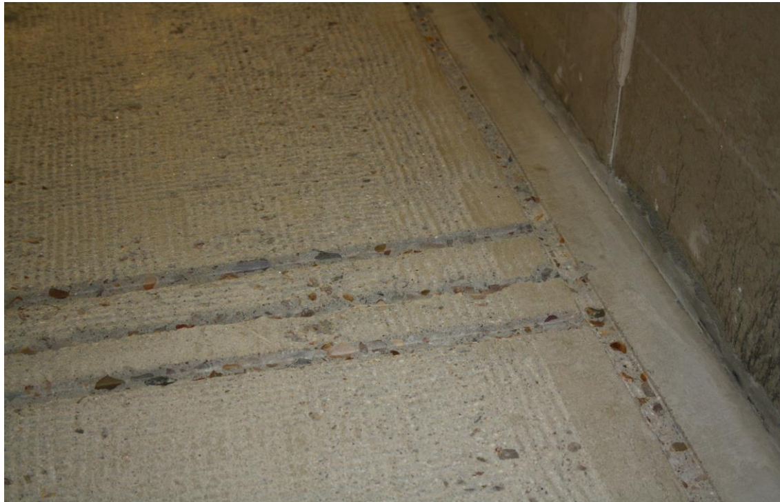
Preparación del soporte mediante fresado en dos capas cruzadas y ejecución de tacones de anclaje / Surface preparation by scarifying in two crossed coats and making of floor groove or keyway
