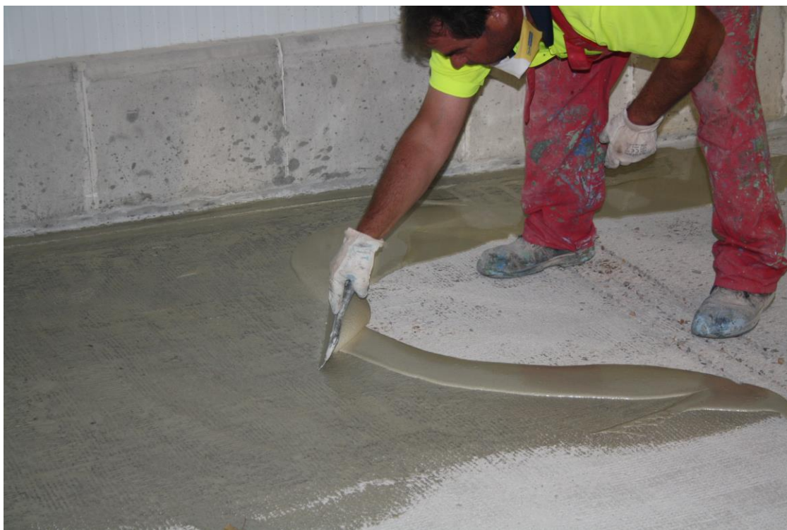
Aplicación de la imprimación MAXURETHANE® CEM PRIMER / Application of primer MAXURETHANE® CEM PRIMER
