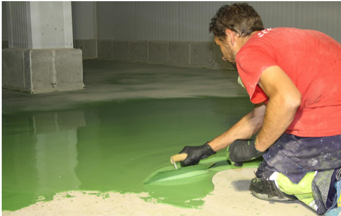
Aplicación de capa base MAXURETHANE® CEM -L con espolvoreo de árido DRIZORO® SILICA 0308 / Application of MAXURETHANE® CEM -L base coat with dust of DRIZORO® SILICA 0308
