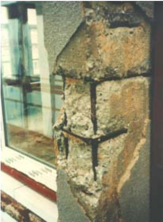
Estado inicial de los pilares de hormigón y armaduras en la fachada. Apreciable el estado de deterioro del hormigón y corrosión de las armaduras.
