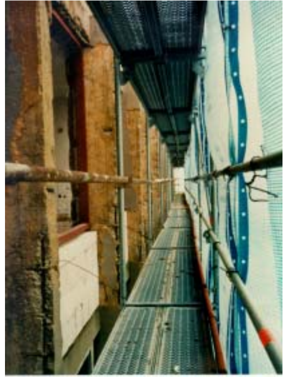
Estado inicial de los pilares de hormigón y armaduras en la fachada. Apreciable el estado de deterioro del hormigón y corrosión de las armaduras.
