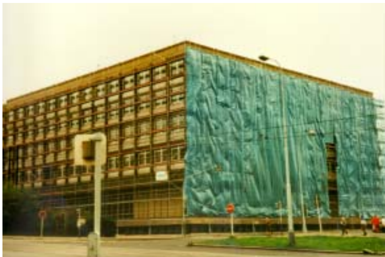
Edificio en Rehabilitación.
