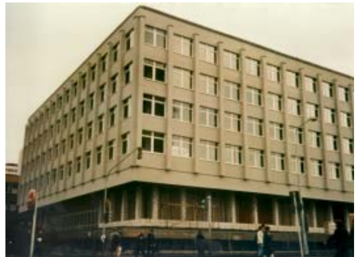
Estado final de edificio restaurado.
